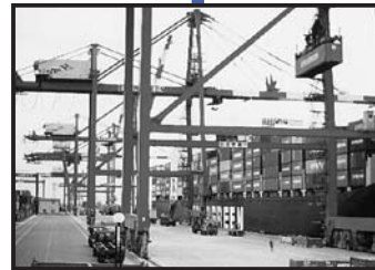
コンテナクレーン走行監視
