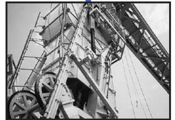
アンローダークレーン作業監視
